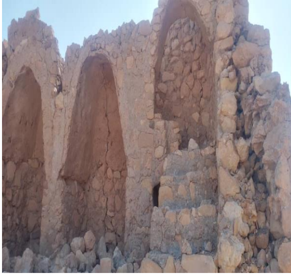
شكل(6) قصر القرينات الغربية متهاك رغم الترميم الواجهة الأمامية
