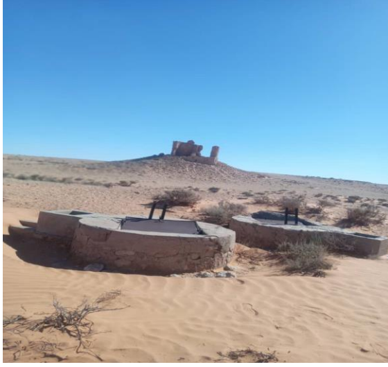
شكل(4) بئر ماء بجانب قصر ذويب ويرتبط بنفق مع القصر وذلك لتخزين المياه
