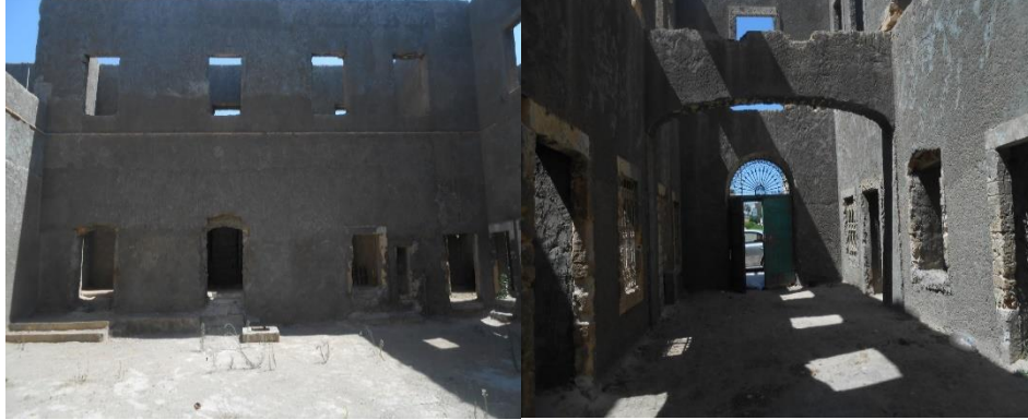
(ب) صور حالية لمبنى السراي من الداخل.
